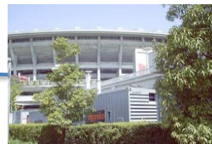
横浜 設置状況
